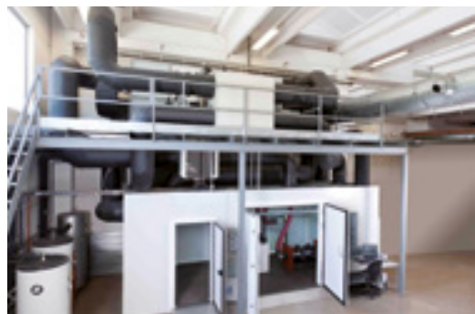
Klimatická komora pro testování rekuperačních jednotek
